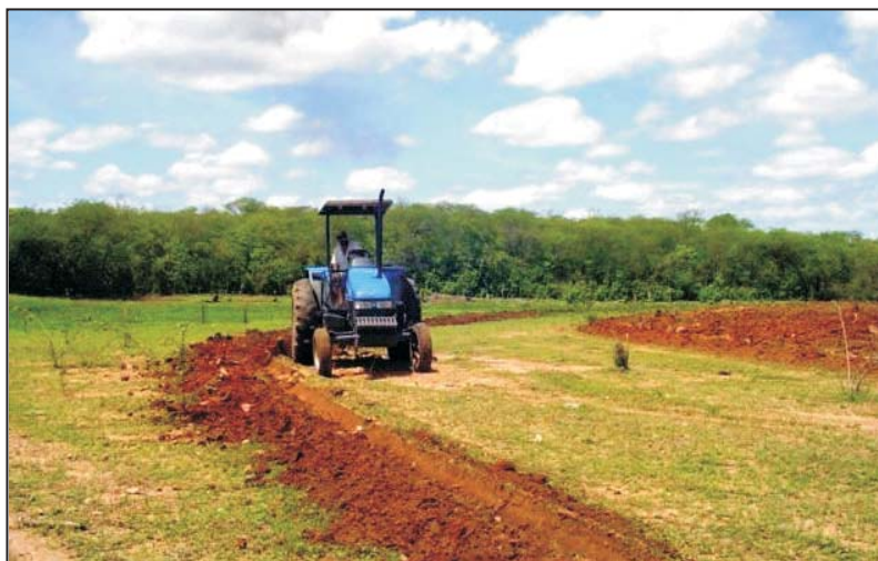
Foto 1 – Construção Terraços Iracema-CE
