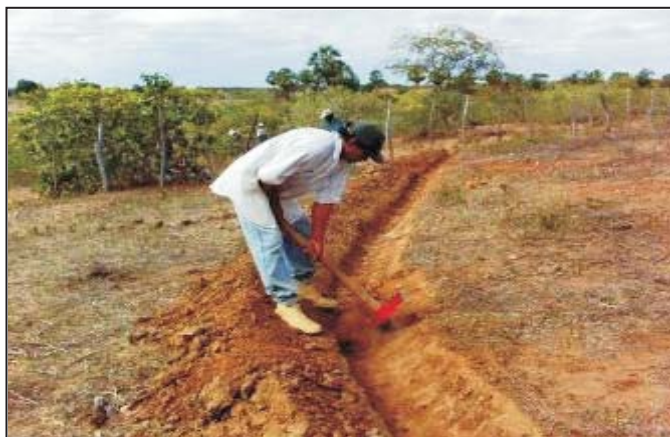
Foto 5 – Cordão – Abertura do Canal
